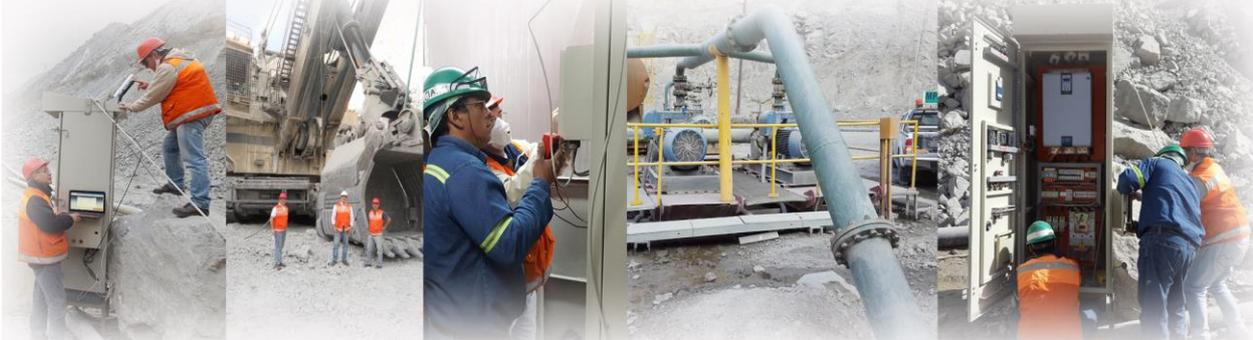
El propósito de la obra fue generar un sistema de Monitoreo de los Pozos del Dewatering de Mina. El monitoreo de los pozos de bombeo del Dewatering ayudó a optimizar el funcionamiento de los mismos, estableciendo un registro en tiempo real y acumulado del funcionamiento de los pozos.
