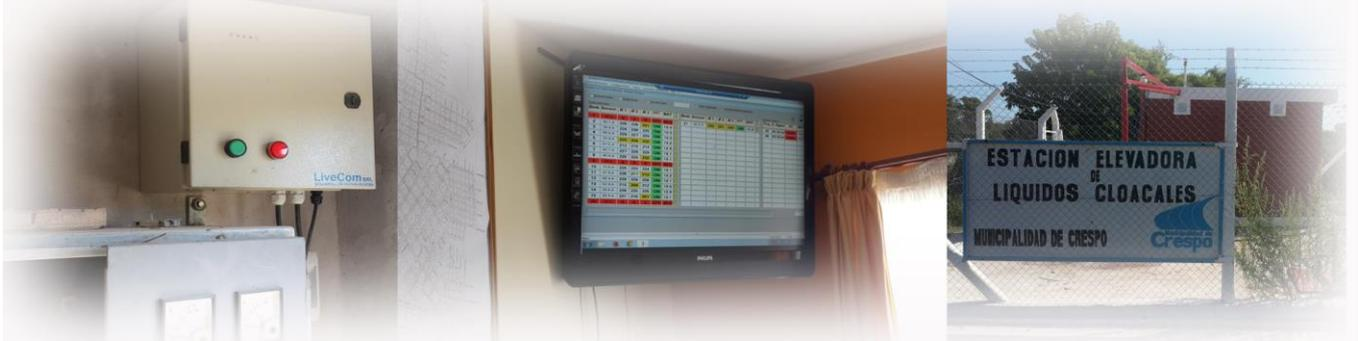
La automatización realizada en la ciudad de Crespo, consiste en medir las presiones de la red de agua potable en distintos puntos, para automatizar el encendido y apagado de las bombas que están conectadas directamente a la red. El resultado inmediato a parte de estabilizar la presión y terminar con el problema de roturas, fue un ahorro de energía eléctrica de un 7.3 %.
